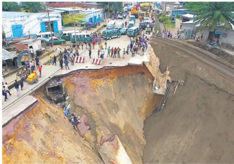
Une érosion /Photo Adiac
