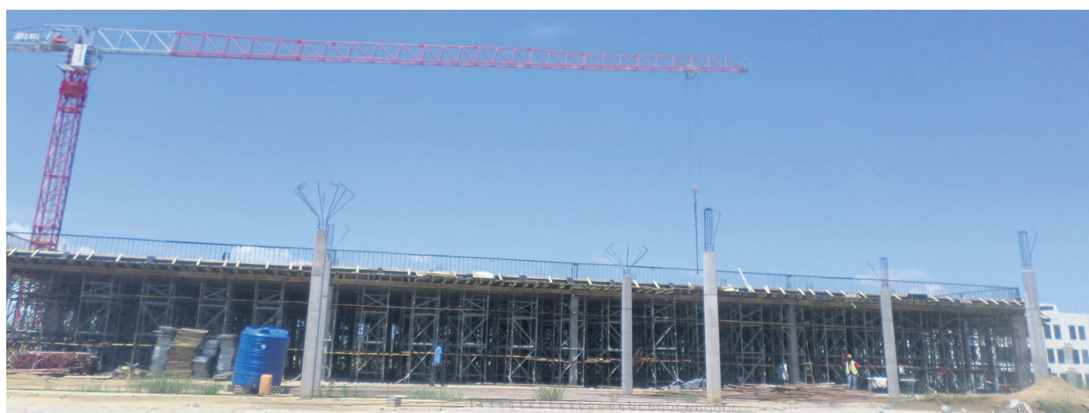
Un bâtiment en construction/Adiac
