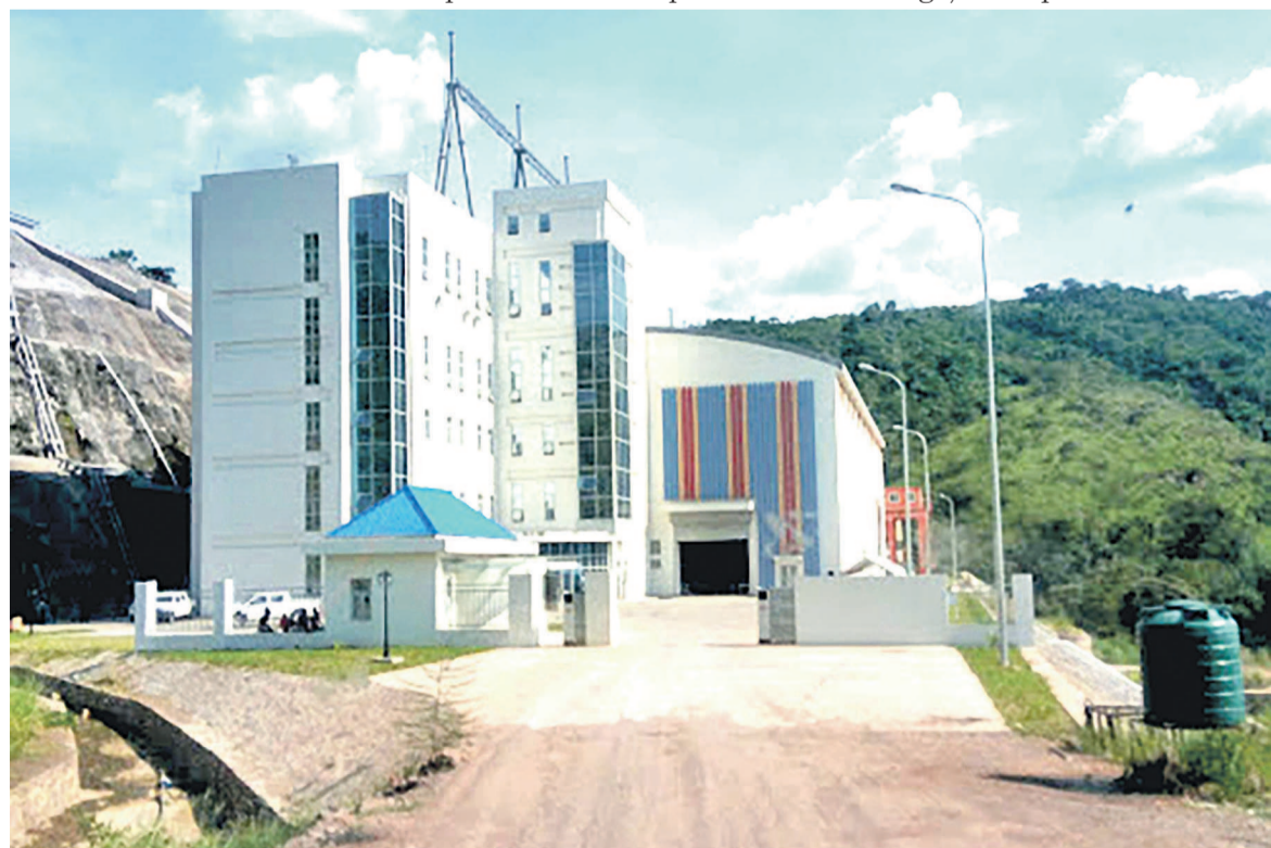
Le bâtiment abritant la centrale hydroélectrique de Zongo II (Kongo-Central)
