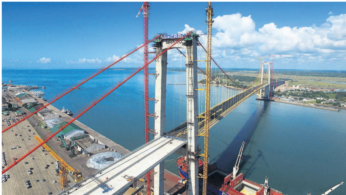
La photo aérienne prise le 8 mai 2018 montre le pont maritime de Maputo, construit par la Chine, à Maputo, au Mozambique. (Xinhua)
