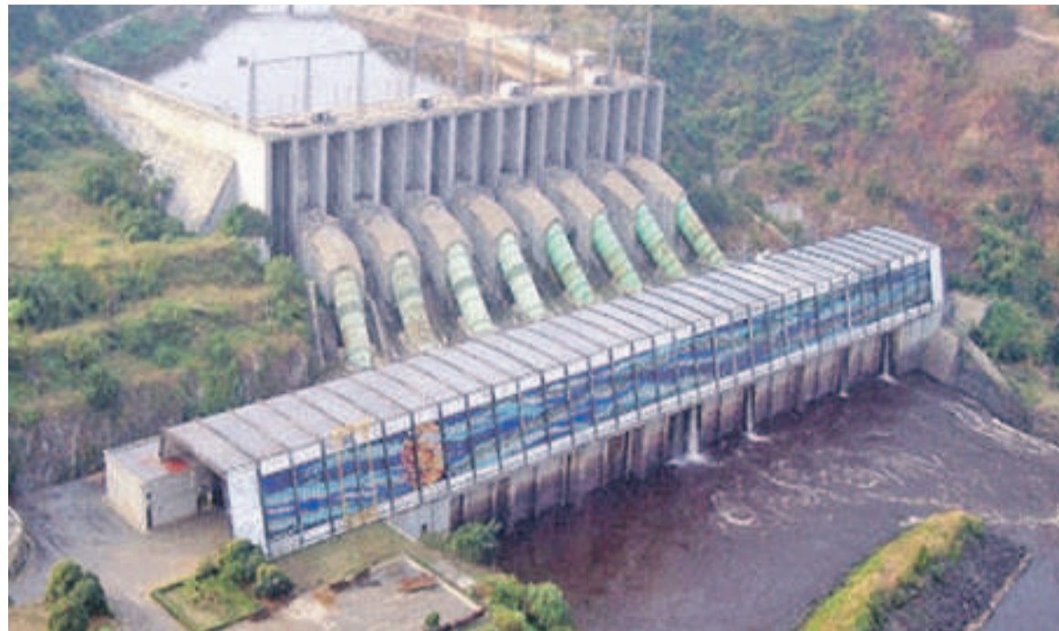
Le barrage d'Inga, symbole de l'électricité en RDC
