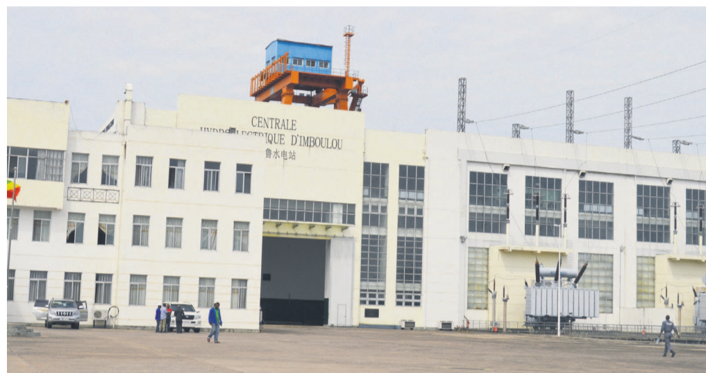
La façade principale du barrage d'Imboulou
