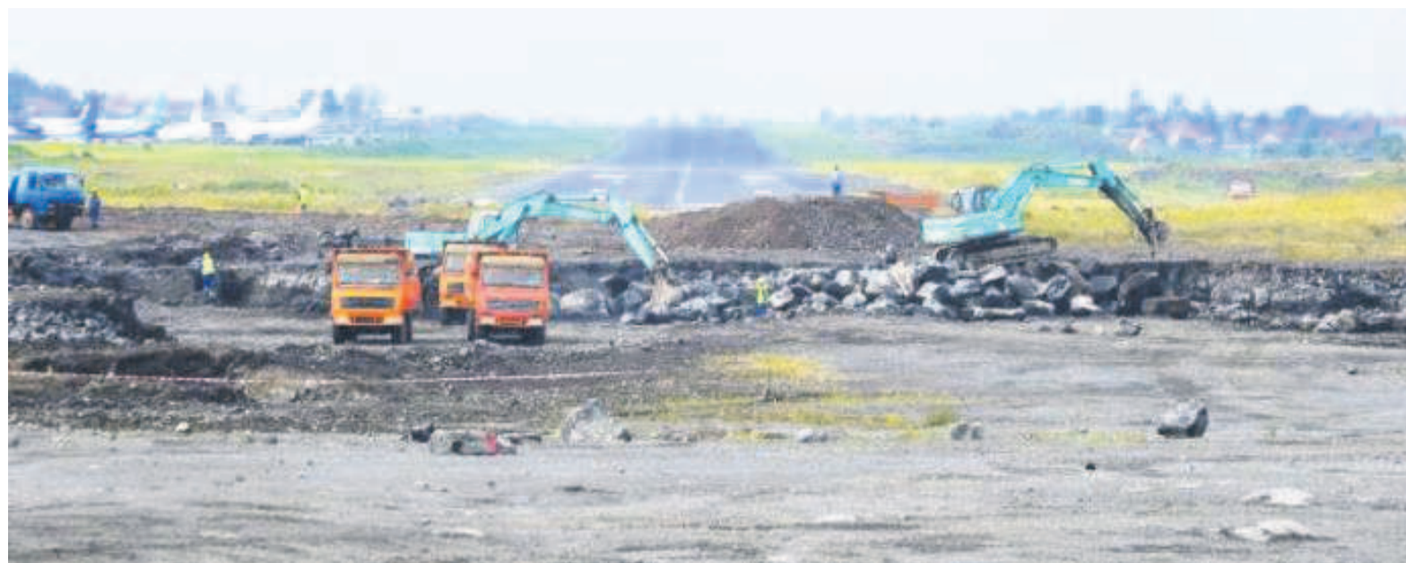
Vue des travaux trois mois après leur lancement./CEPTM
