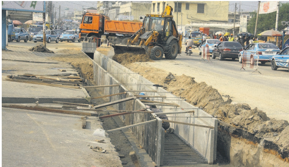
Construction de caniveaux sur le boulevard Moe-Katt-Matou crédit photo «DR»
