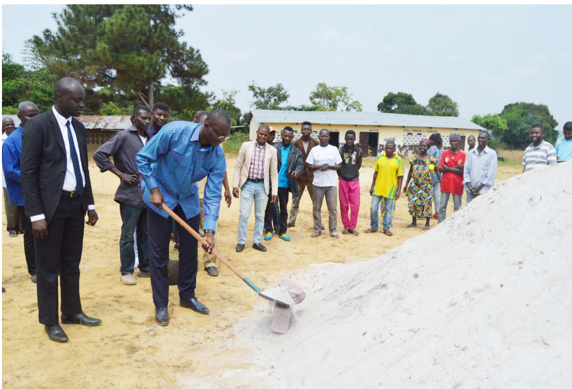
Le coordonnateur de Hope Congo lançant les travaux
