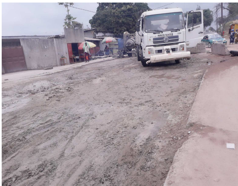
L'avenue Château d'eau à Makélékélé en réhabilitation
