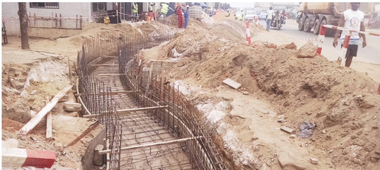
Les travaux de canalisation à Siafoumou/DR
