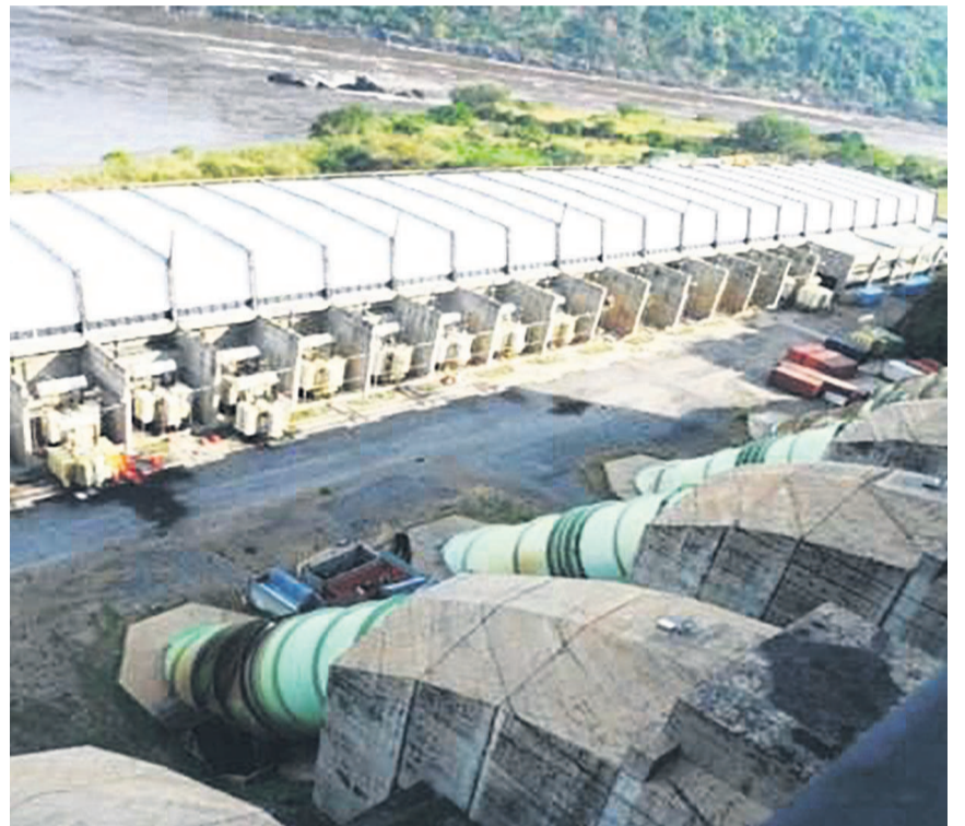
Barrage hydroélectrique Inga II
