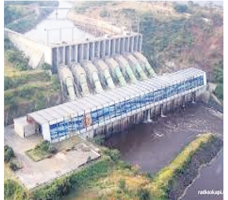
Une vue du barrage d'Inga
