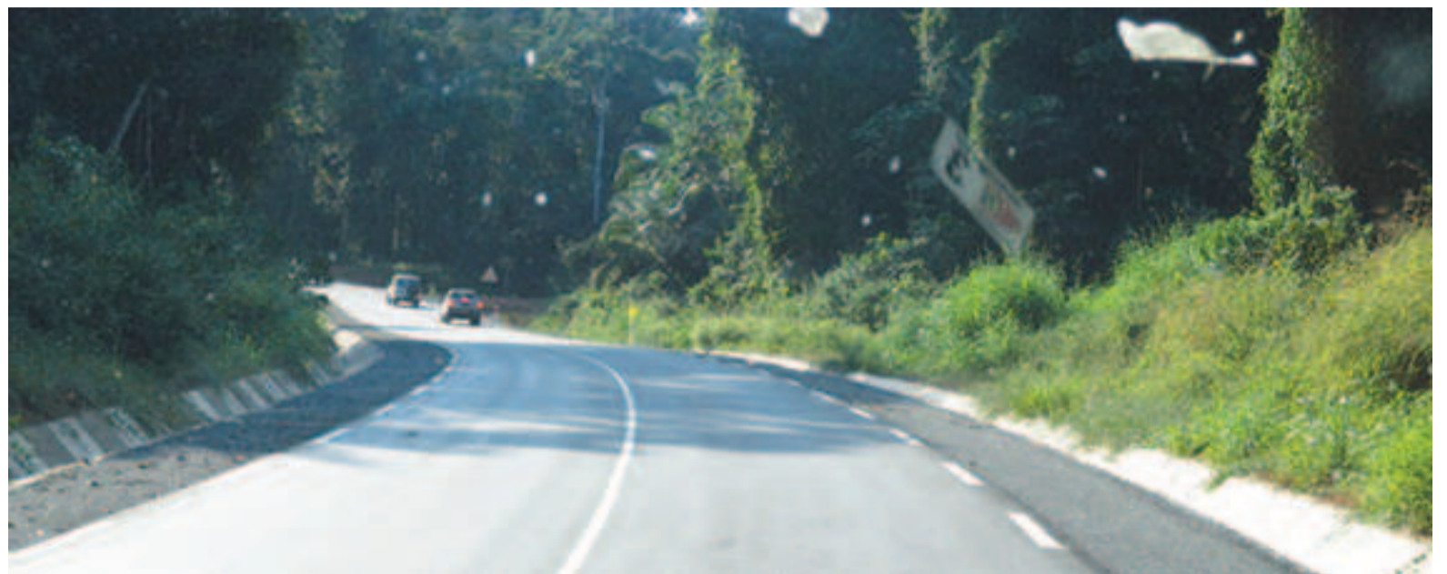
Vue partielle de la route Ketta-N'Tam
