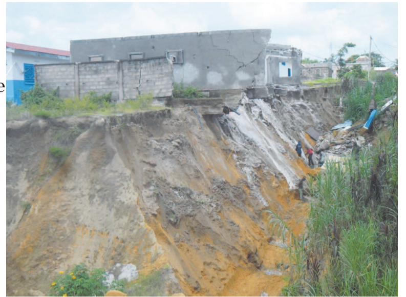
Une érosion au quartier Domaine, dans le neuvième arrondissement Djiri/Adiac
