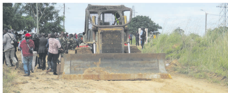
Emile Ouosso lançant les travaux de la route des forestiers, à Ewo
