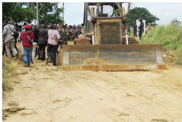
Emile Ouosso lançant les travaux de la route des forestiers, à Ewo
