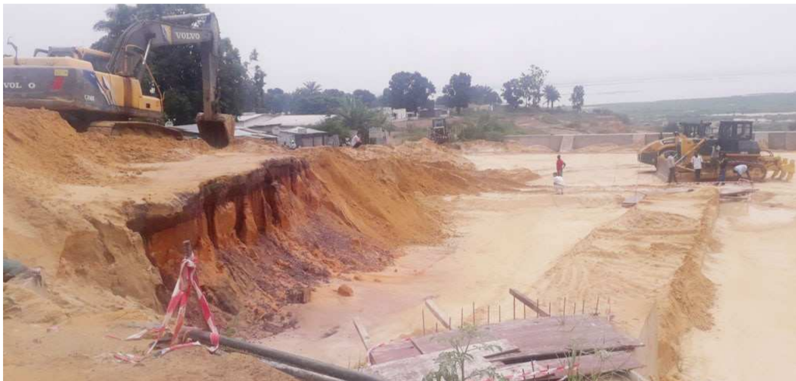
Une partie de l'érosion quasiment traitée en totalité
