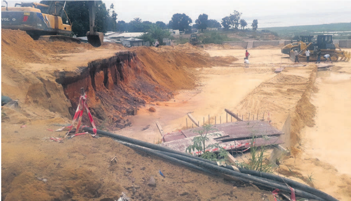
Une partie de l'érosion quasiment traitée en totalité
