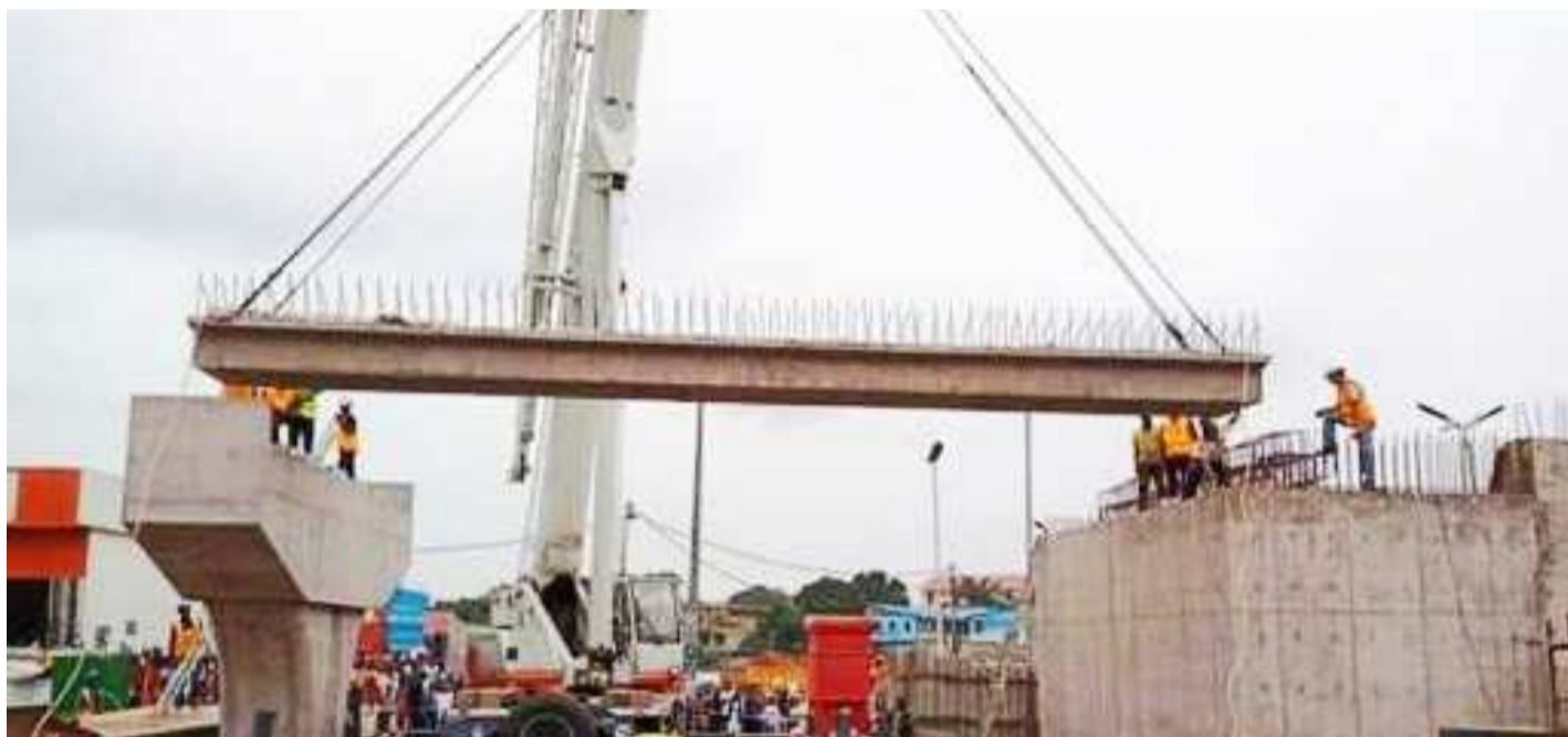
Un chantier de saut-de-mouton à Kinshasa.
