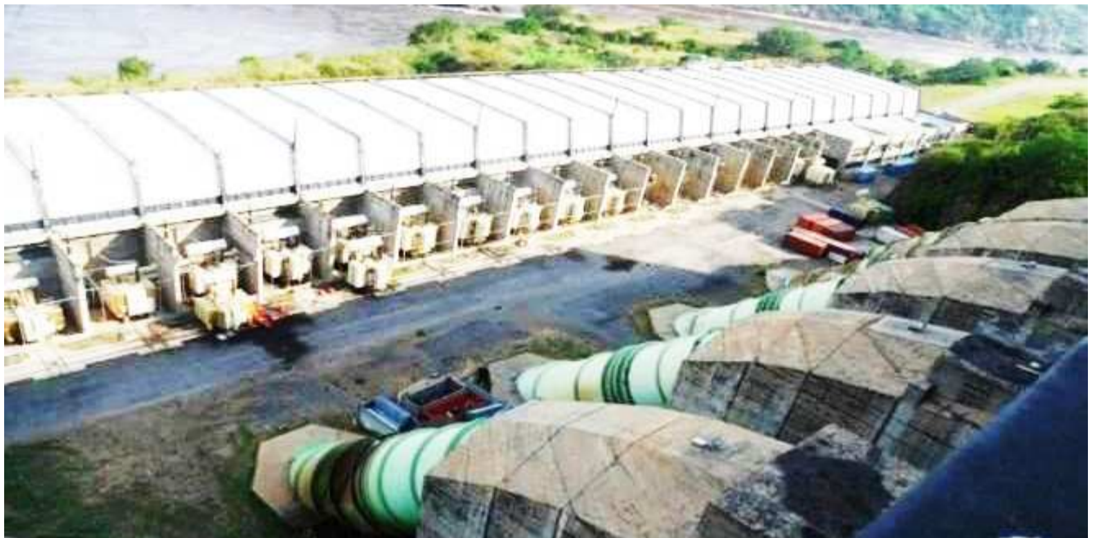
Barrage hydroélectrique Inga II
