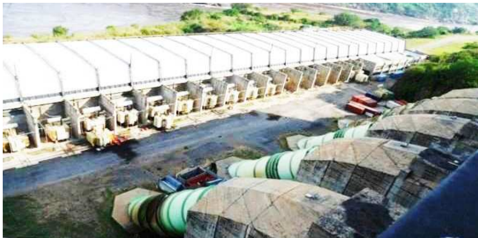
Barrage hydroélectrique Inga II
