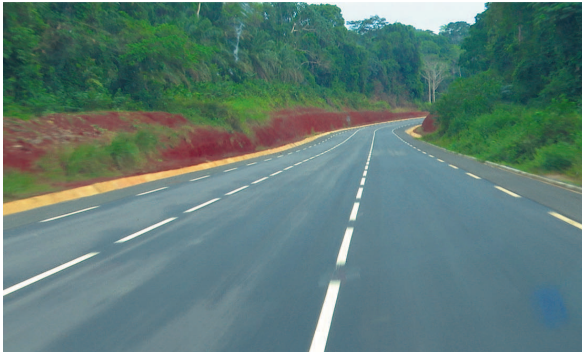
Une vue du tronçon routier Sembé-Souanké-Ntam
