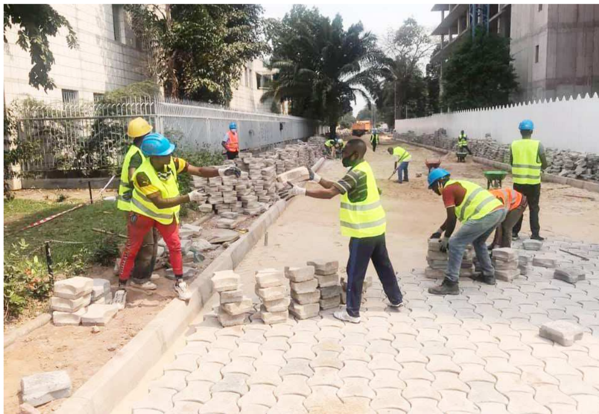
Pose des dalles sur le tronçon entre l'IFC et le futur siège du ministère de l'Intérieur/Photo DR
