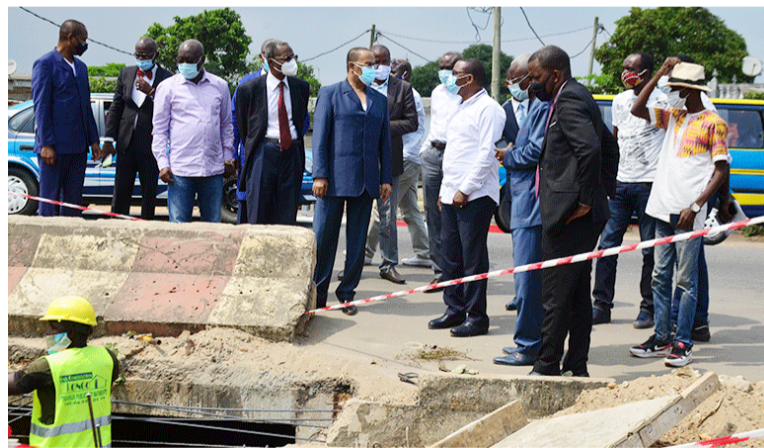
Le ministre et la délégation municipale visitant les travaux crédit photo DR
