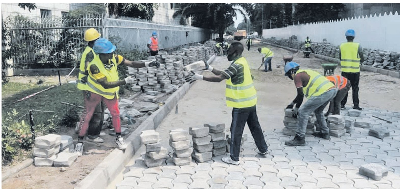
Pose des pavés sur le tronçon entre l'IFC et le futur siège du ministère de l'Intérieur/DR
