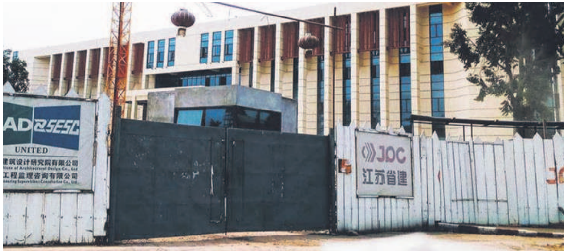
Les travaux de finition du bâtiment/Adiac
