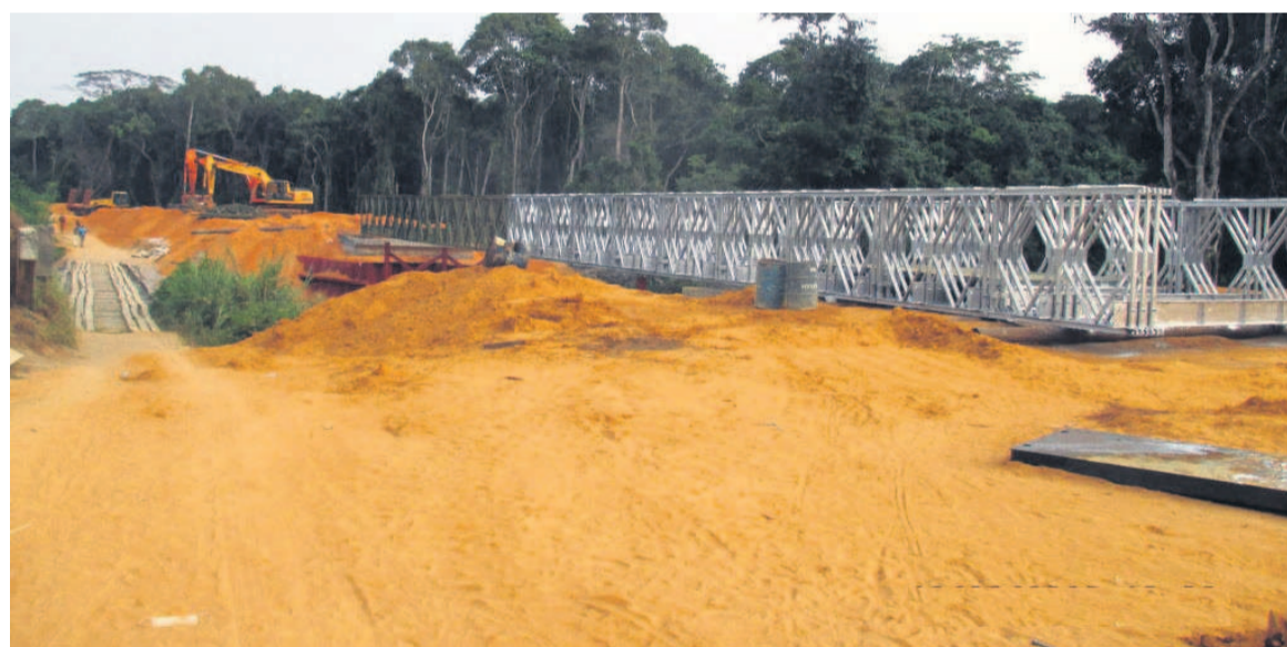
Une vue du nouveau pont en cours de réalisation/DR
