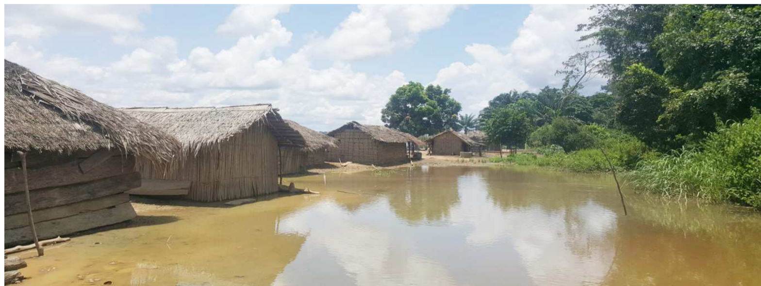
Des habitations inondées
