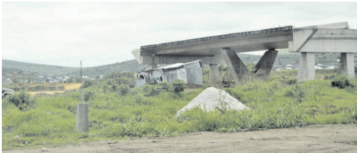
Une vue du viaduc inachevé
