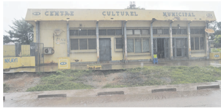
La façade principale du Centre culturel municipal de Nkayi
