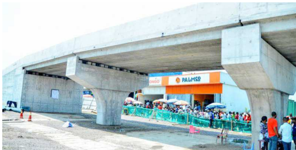
Une vue de sauts-de-mouton de Pompage
