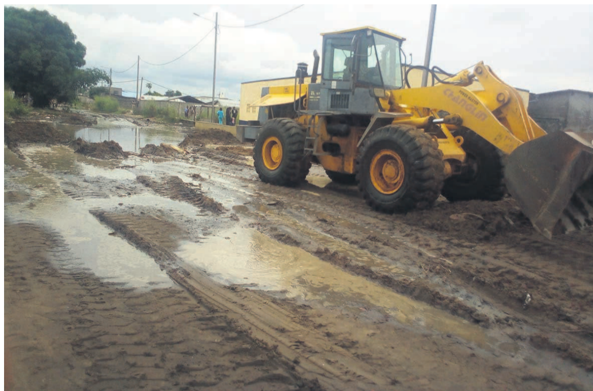
Un engin des travaux publics
