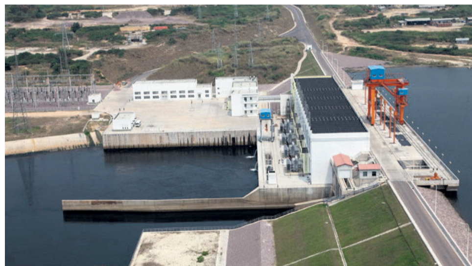
Le barrage d'Imboulou
