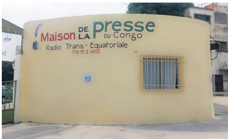
Le local abritant la nouvelle chaîne de radio
