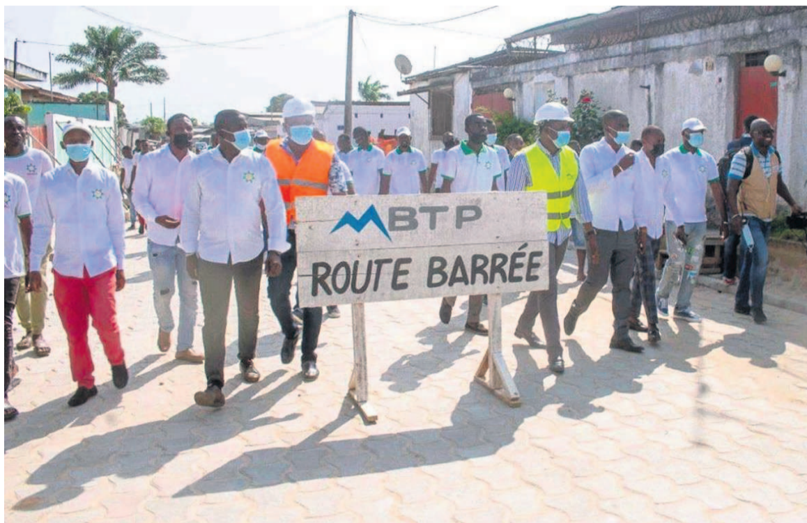
Les membres de la DGMCA visitant les travaux de voirie urbaine
