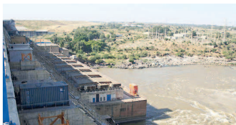
Une vue partielle du Grand Barrage de Renaissance
