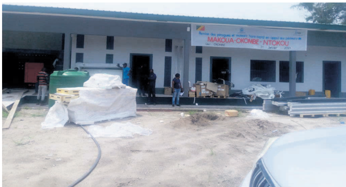
Vue d'un des modules du centre communautaire de pêche
