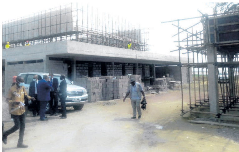
Une vue des infrastructures en construction
