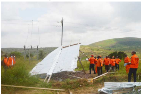
Démolition des habitations anarchiquement érigées
