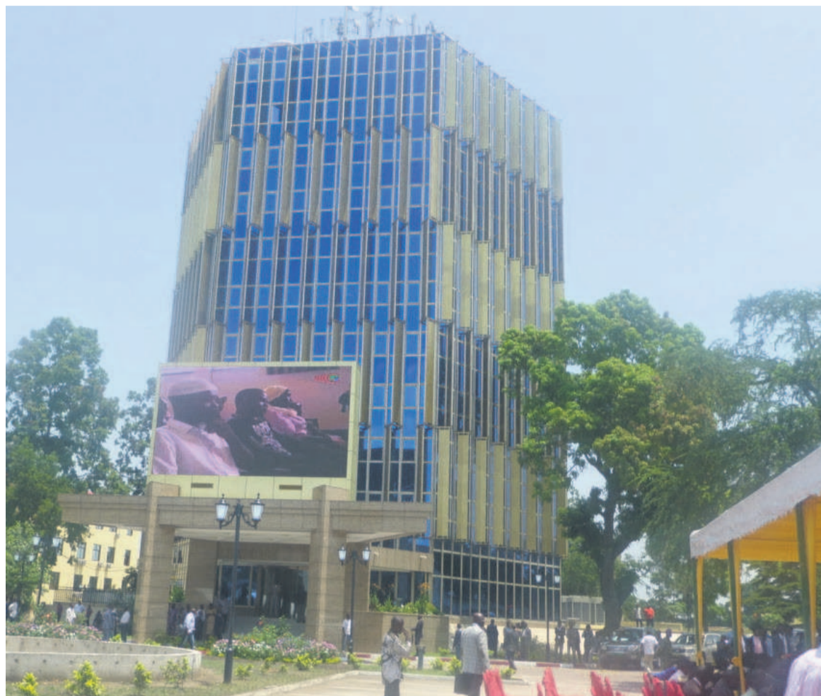
Façade principale du ministère de l'Aménagement du territoire, des Infrastructures et de l'Entretien routier/DR
