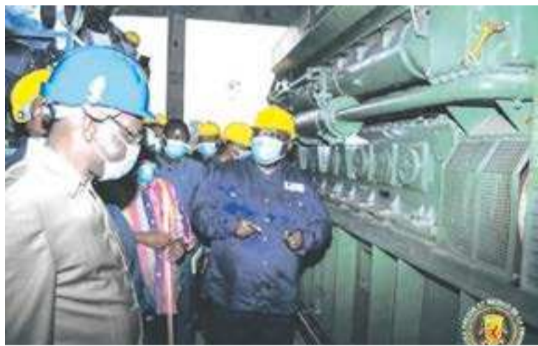
Le Premier ministre visitant le chantier DR
