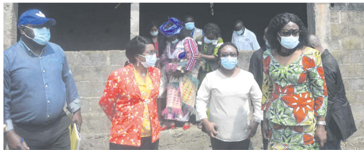
La ministre et les autorités visitant un des bâtiments dont les travaux se poursuivent
