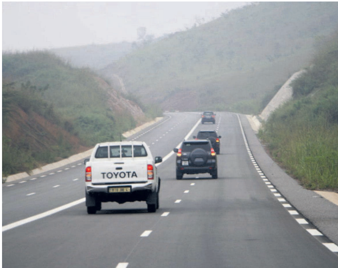
Un tronçon de la route nationale n°1
