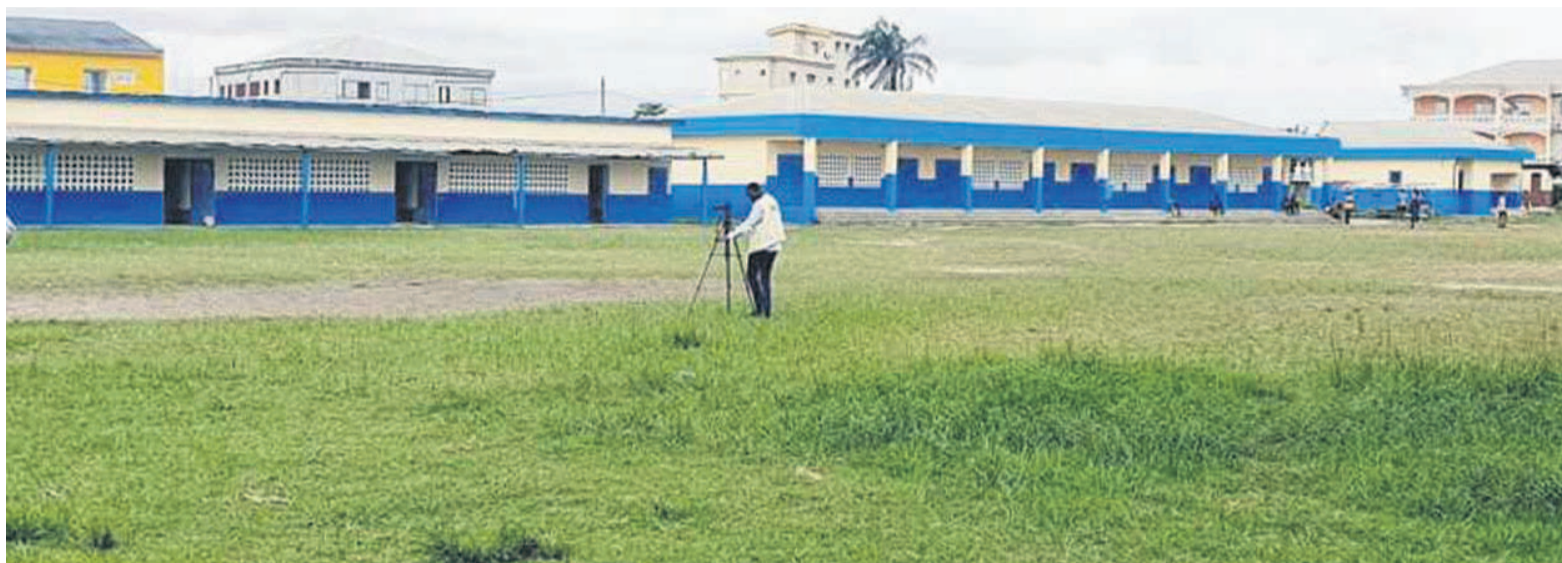
Le complexe scolaire de Tchimbamba rénové./Adiac
