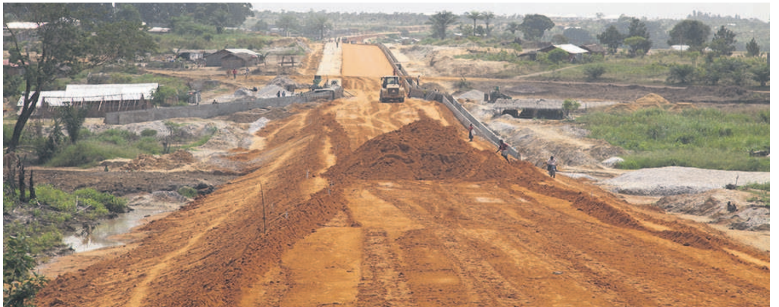
Les travaux de voirie à EwoDR
