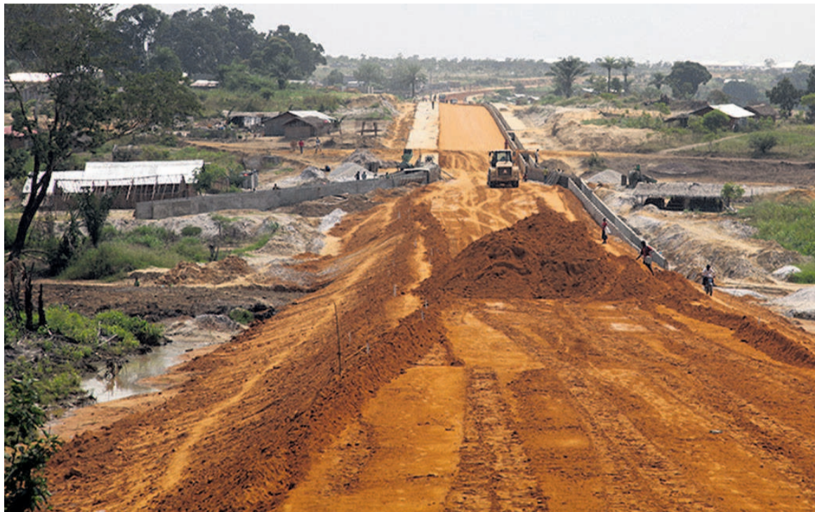
Les travaux de voirie à Ewo/DR
