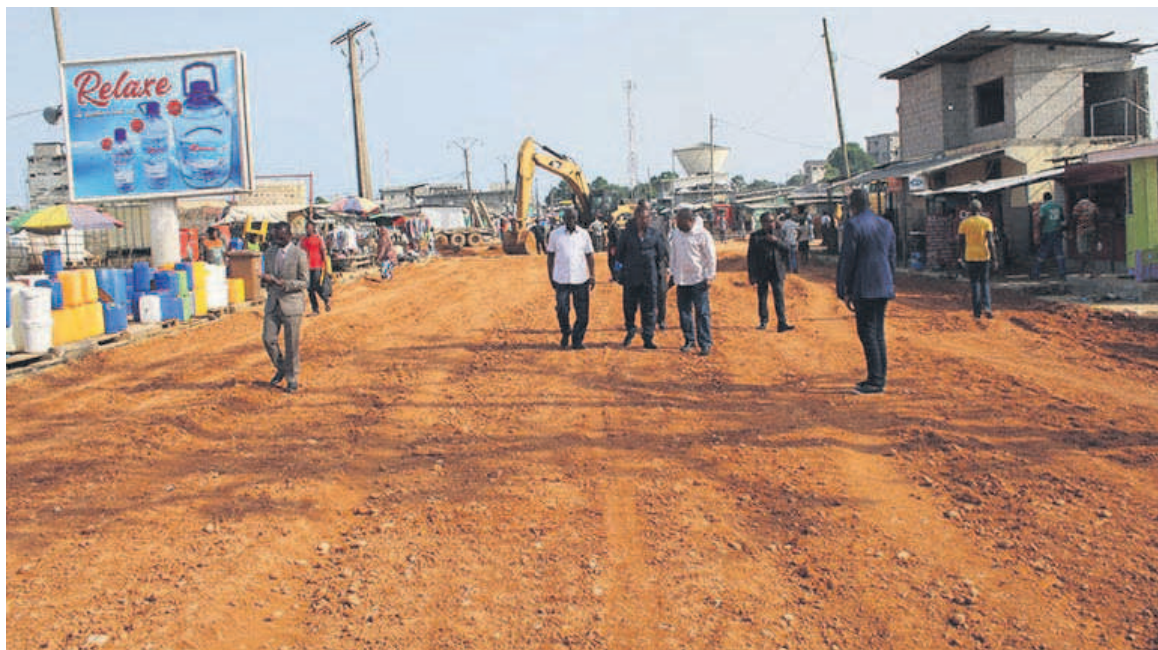
Une route en construction/DR
