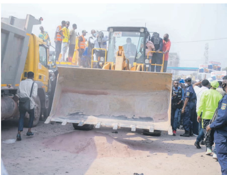
Le gouverneur Ngobila, sur une pelle chargeuse, lançant les travaux. DR
