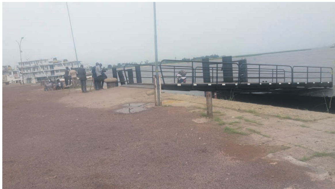
Le quai du port à passagers réhabilité/Adiac
