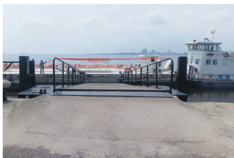
Une vue de la passerelle réhabilitée
