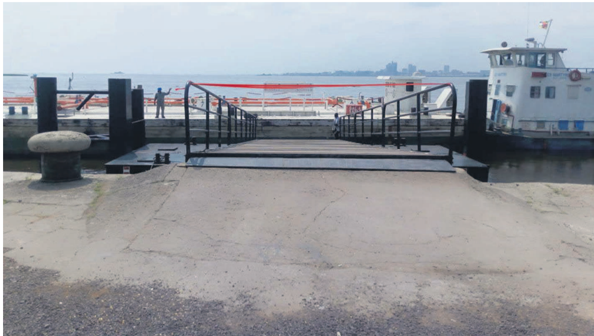
Une vue de la passerelle réhabilitée DR
