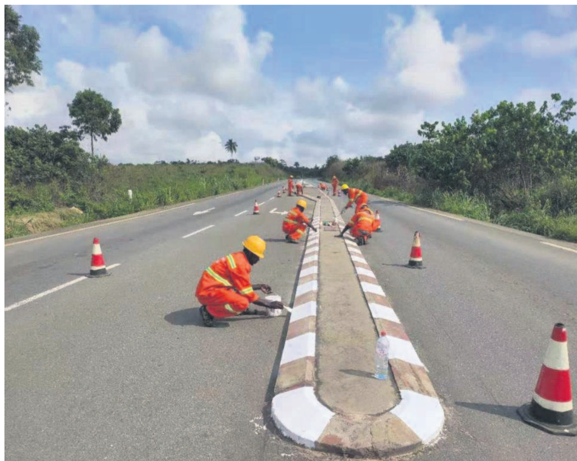
Des travaux sur la nationale 1/DR
