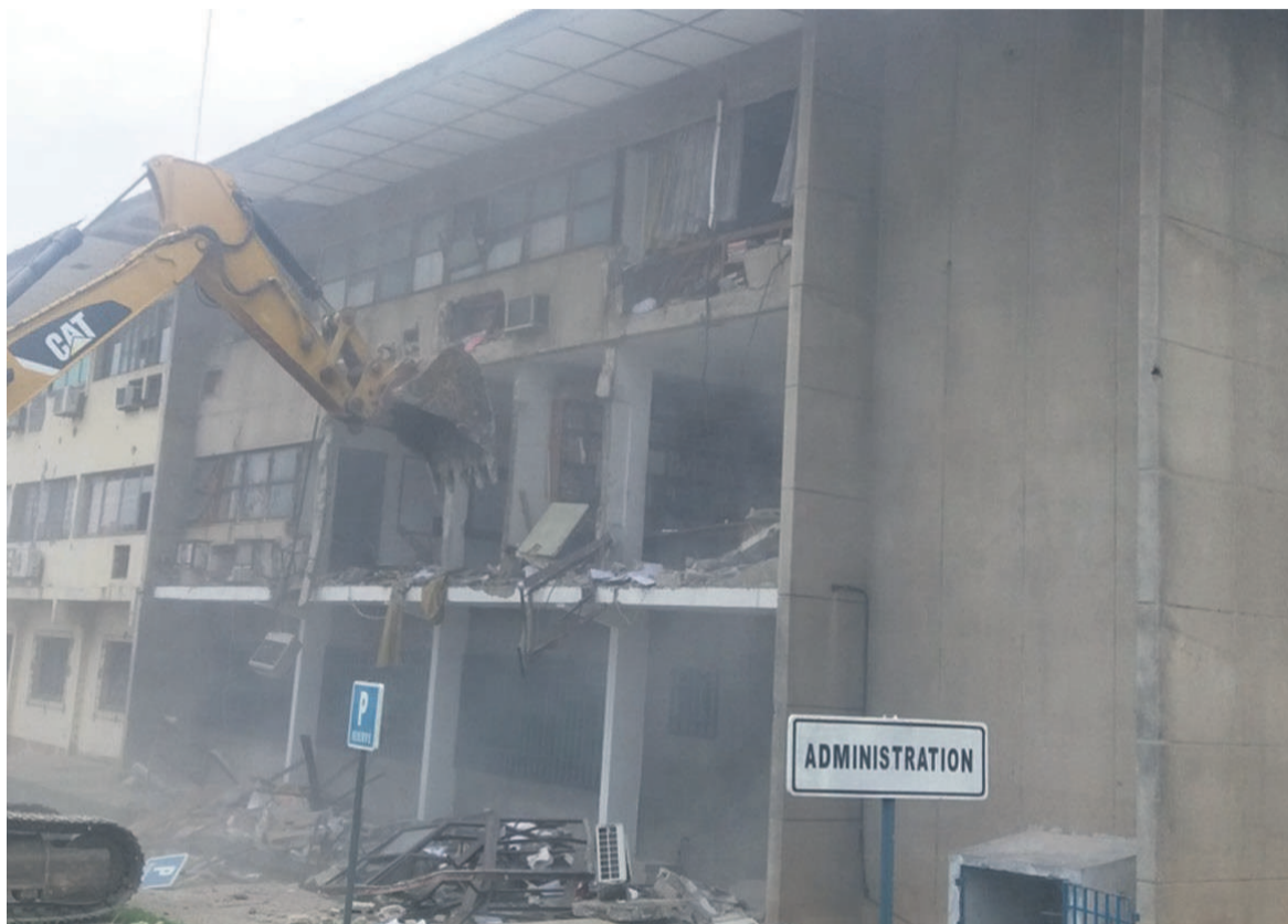
Un vieux bâtiment abritant la direction générale du CNTF en train d'être démol/Adiac
