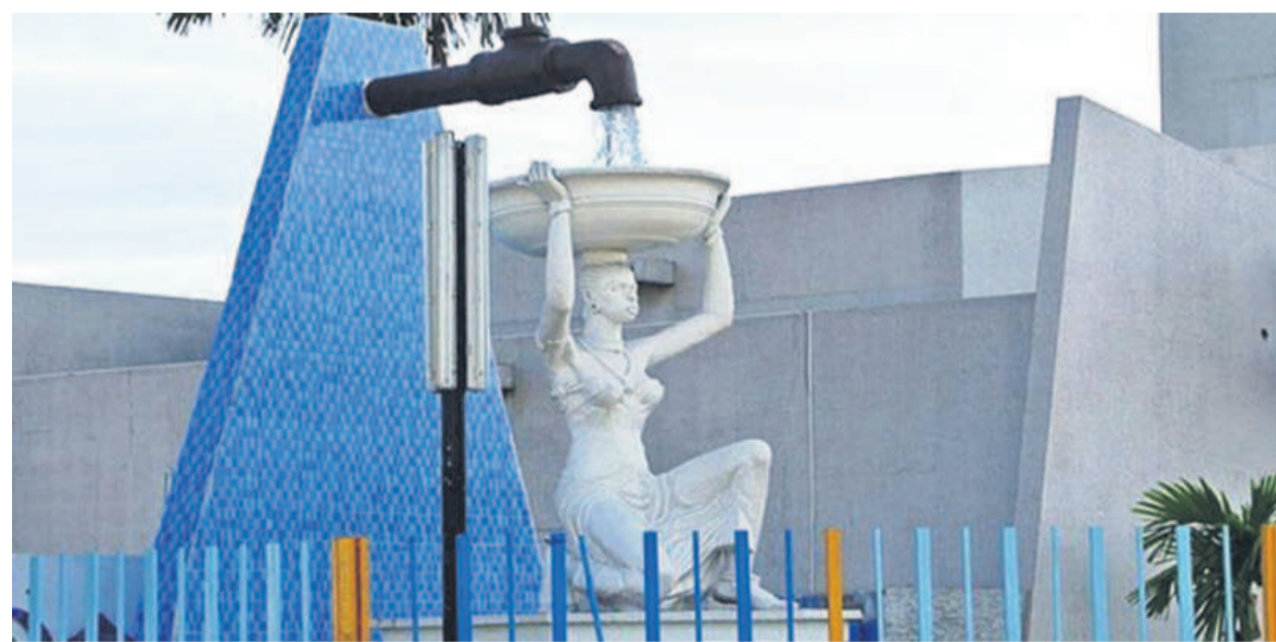
Une fontaine installée dans la direction générale de la RégidesoDR
