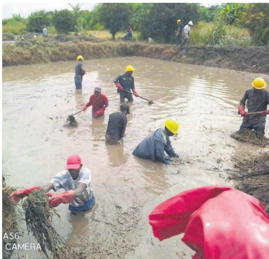
Réhabilitation des étangs des communautés touchées/Afrewatch
