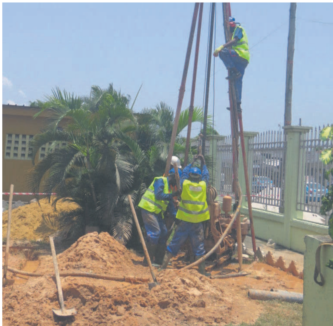
La construction du forage de l'hôpital de base de Tié-Tié/Adiac
